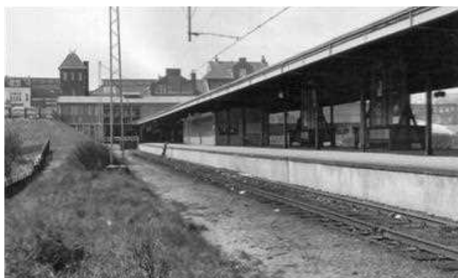
Fraaie perronoverkapping in de jaren 70, helaas ook afgebroken.
