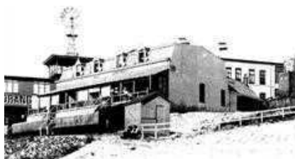
De villa Lichttoren in de avondzon. De villa met conciërge woning, bestond uit o.a. 10 kamers en 2 keukens. Rechts staat nog de oude vuurtoren.
