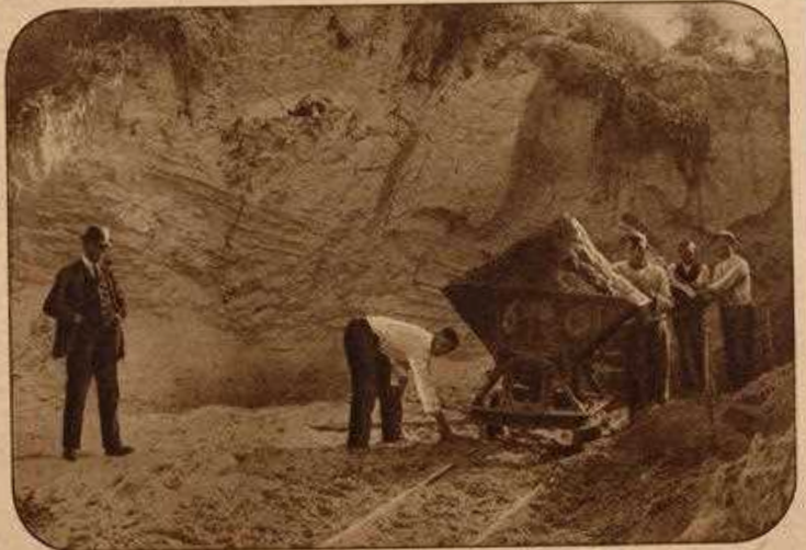
Het vervoeren van het afgegraven zand per wiegkar.
