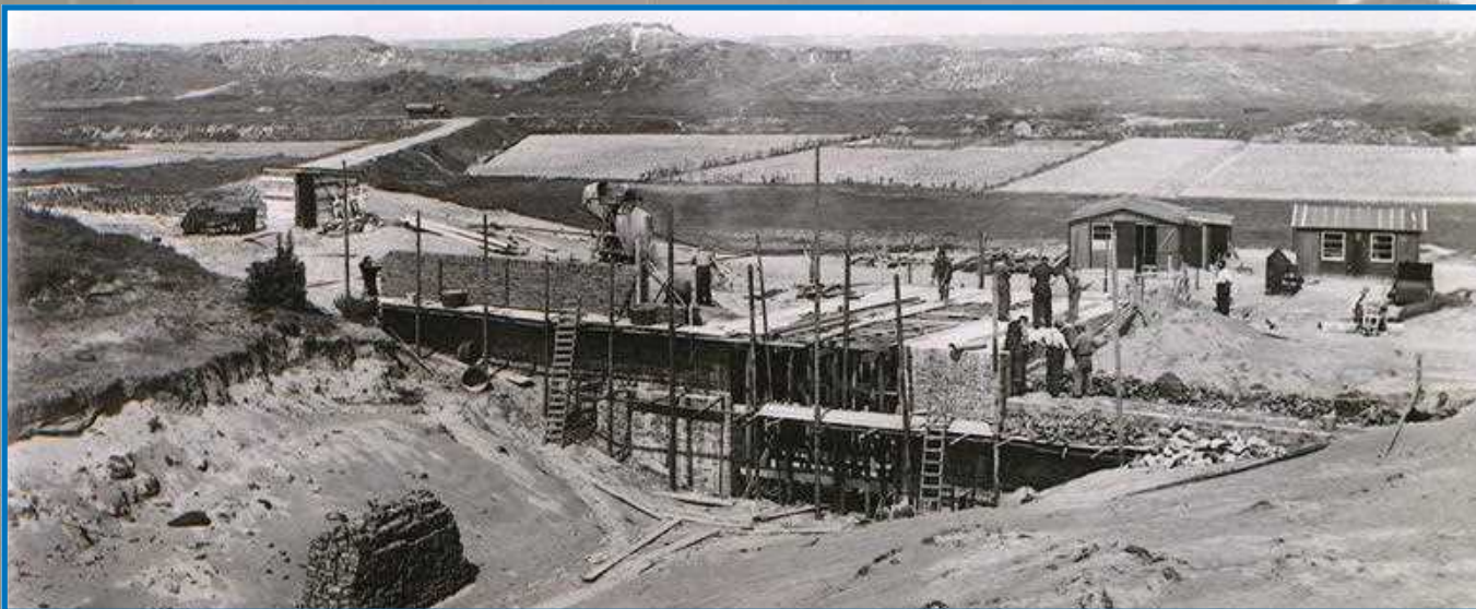
De bouw van Tunnel Oost
