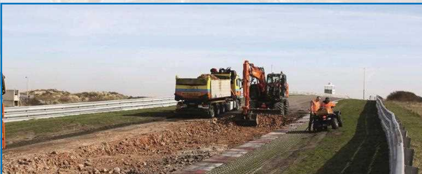
Maart 2017 – het circuit krijgt een nieuwe asfaltlaag, de oude ondergrond verdwijnt (foto facebookpagina Circuit Zandvoort)
