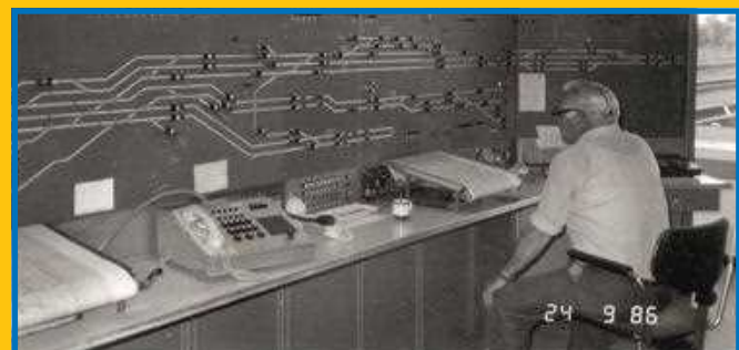
Het 'knopjesdrukken' gebeurde op de NX post in Haarlem. Treindienstleider Opheikens kijkt hier naar het tableau. Treinen zag je niet meer, alleen op het tableau door 'bezetlampjes'.
