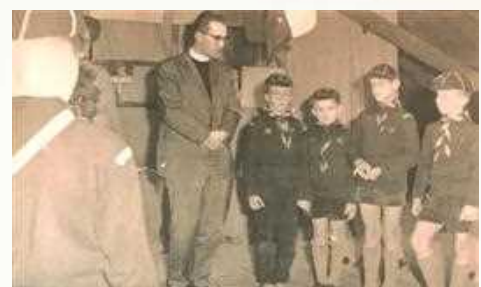
Installatie van de welpen op de zolder van de Mariaschool
