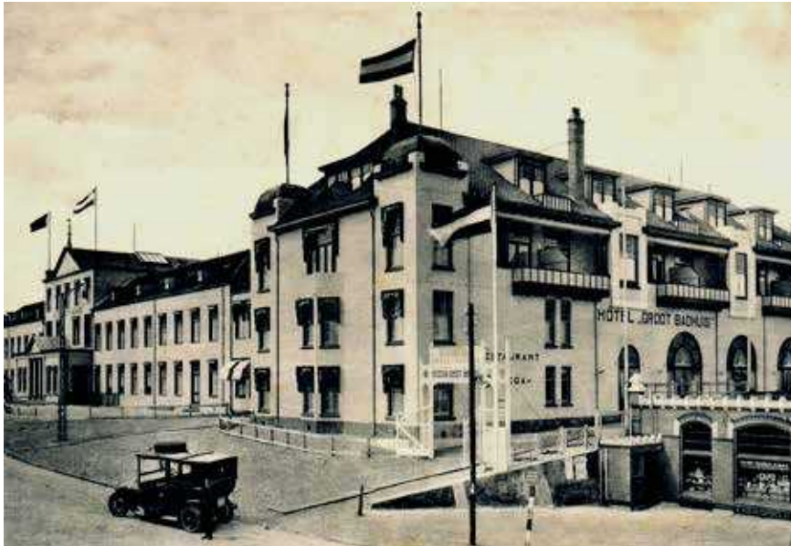
In 1906 en 1907 werd het Groot-Badhuis flink uitgebreid. Op het oude hotel werd een verdieping gebouwd en evenwijdig aan de Strandweg werd een nieuwe vleugel opgetrokken.
